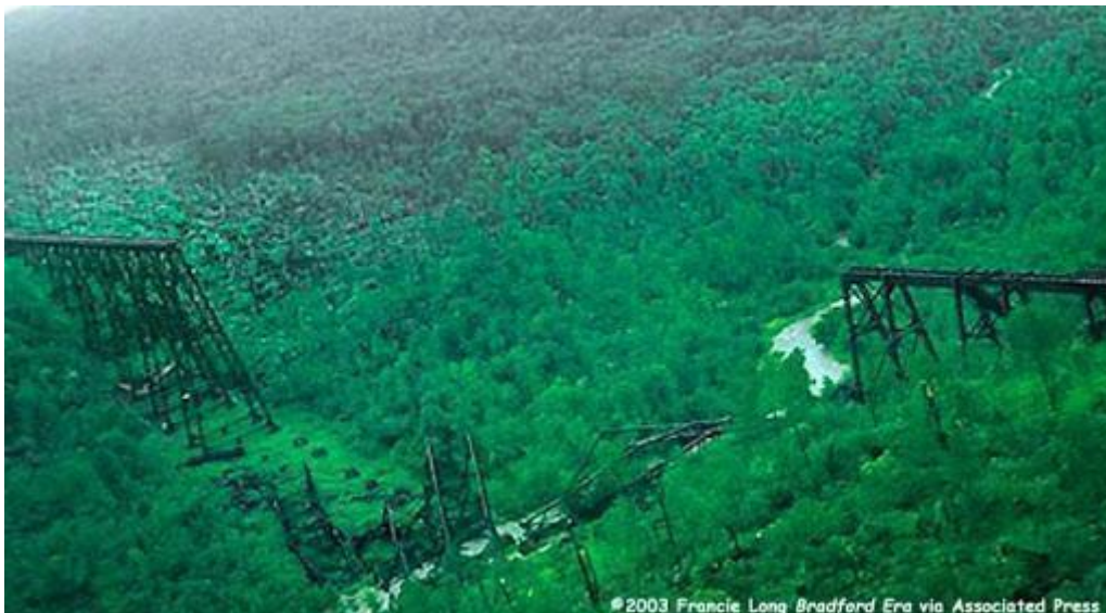
Figura 3: Viaduto Kinzua, após o seu colapso
