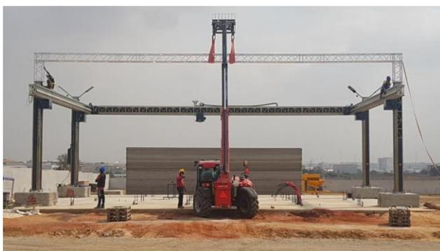
Figura 2 – Montagem da impressora
